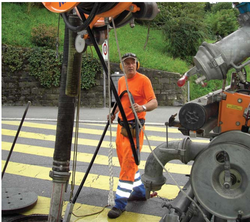
Unterhaltsarbeiten an der Kanalisation.
